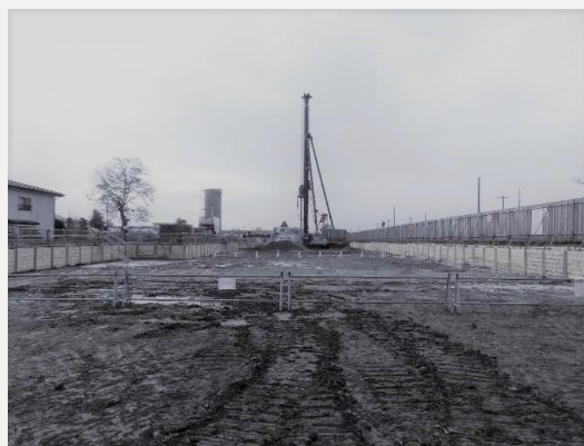
新庁舎北側より 地盤杭打ち（2019.11時点）
