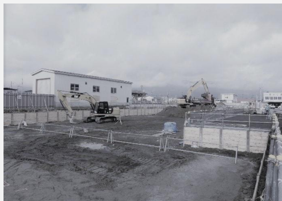
新庁舎南側より 根切り工事（2019.11時点）
